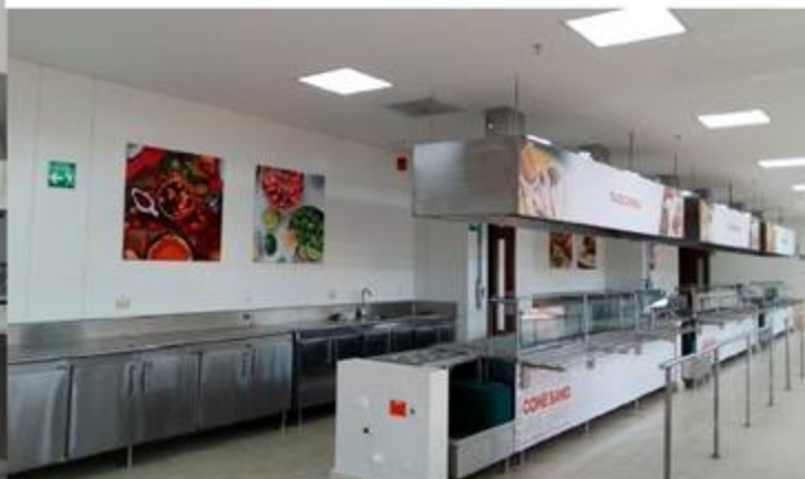
Resultado final después de la intervención de ServiHoteles-Newrest al comedor ECartagena.
